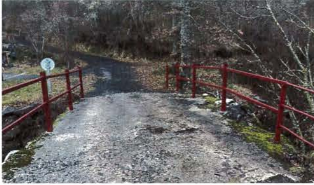
Pont à Bikini Restauration des balustrades
