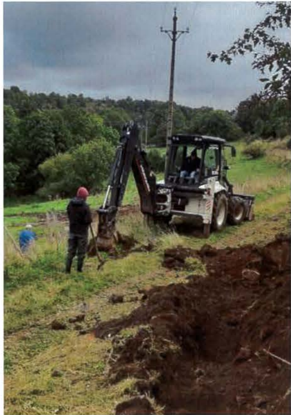
Recherche et réparation d'une fuite d'eau à Bikini
