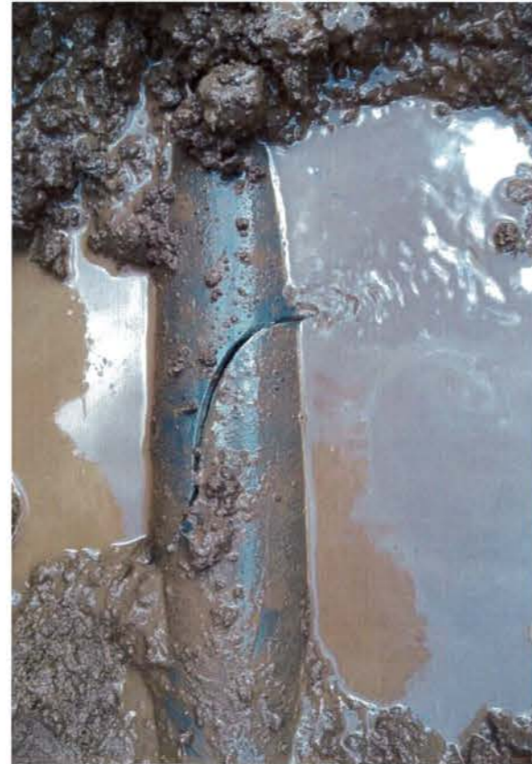
Recherche et réparation d'une fuite d'eau à Bikini
